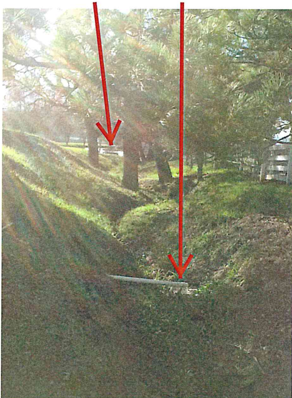
Pond / Pond Fill Pipe
